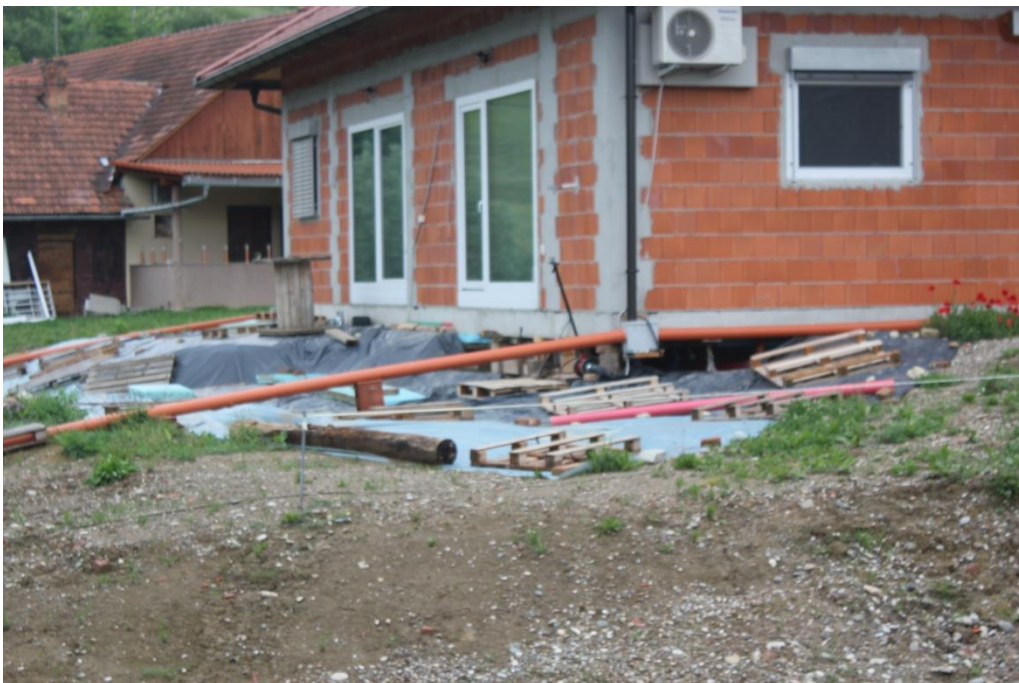
Pogled na odlomni rob plazu na JV delu hiše, kateri je podprt z hidravličnimi dvigalkami.
