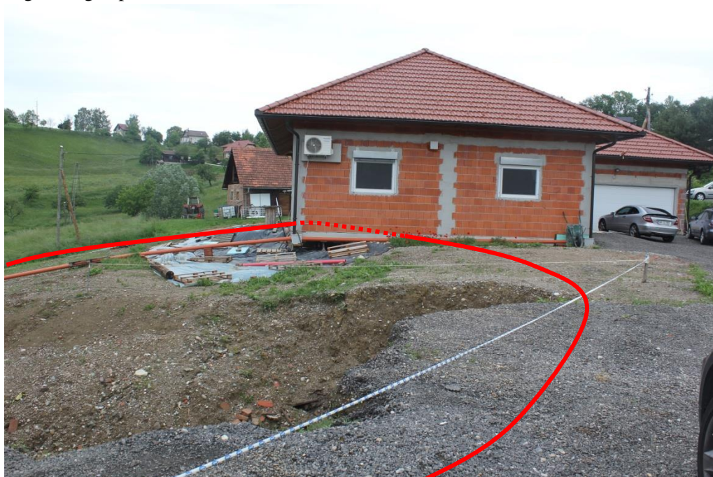
Pogled proti stanovanjski hiši, kjer se vidi odmik terena pod objektom in linija odlomnega roba.
